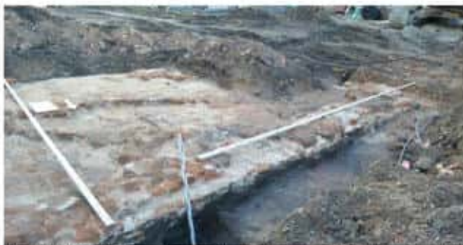
Przyziemie budynku gospodarczego odkrytego przy narożniku północno-zachodnim przychodni specjalistycznej, widok od północnego-wschodu.
