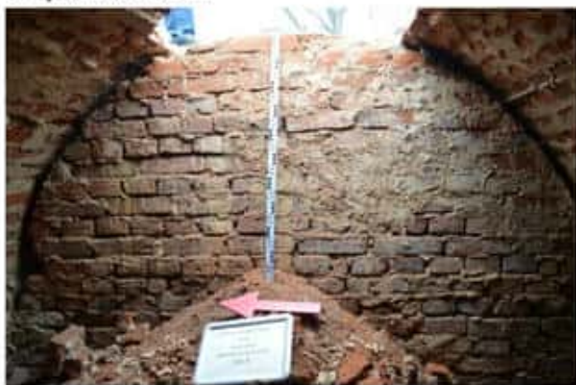
Wschodnia część piwnicy pod oficyną północno-wschodnią.
