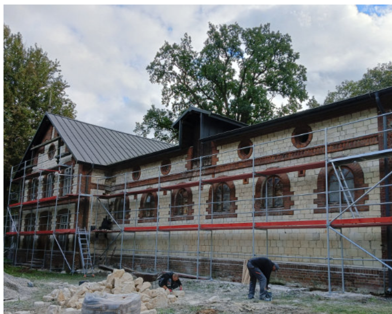
Budynek powozowni podczas prac remontowych
