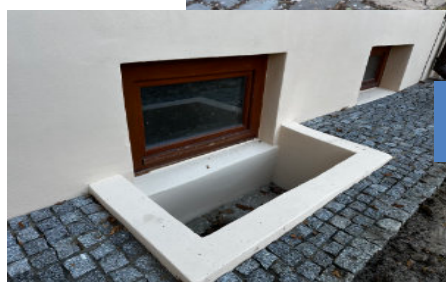
Opaska z kostki granitowej dookoła budynku ze spadkiem odprowadzającym wodę
