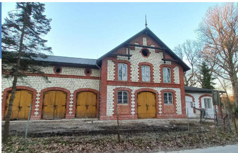
Budynek powozowni przed remontem
