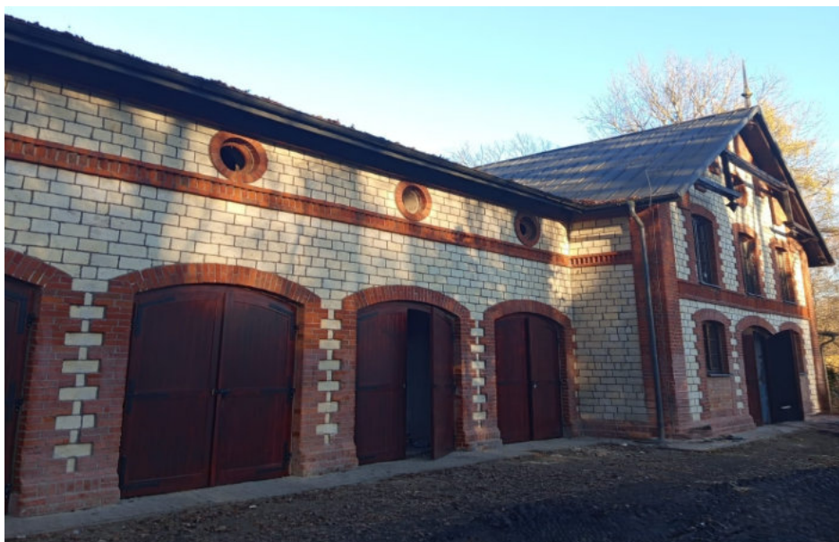
Budynek powozowni po renowacji
